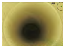
Bild 15 Dicht saniertes Schadensbild (keine Auffälligkeiten)
